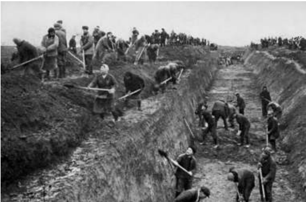
Строительство оборонительных сооружений под Москвой. Осень 1941 г.
