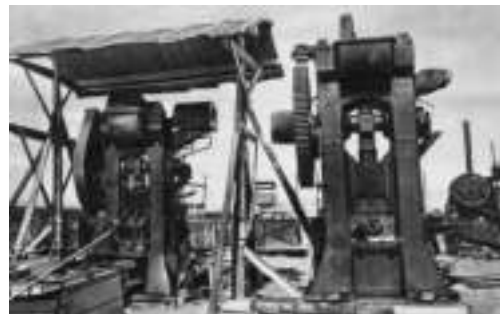
Монтаж оборудования на эвакуированном заводе. Казахстан. 1942 г.
