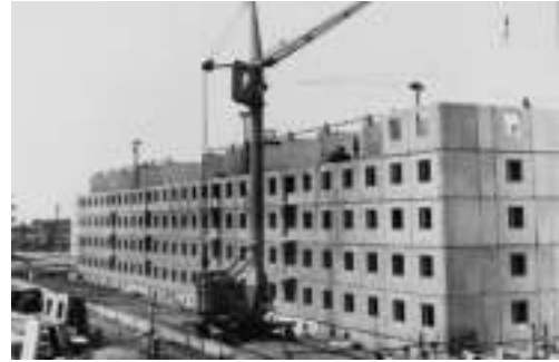
Строительство пятиэтажного жилого дома. Город Волжский
