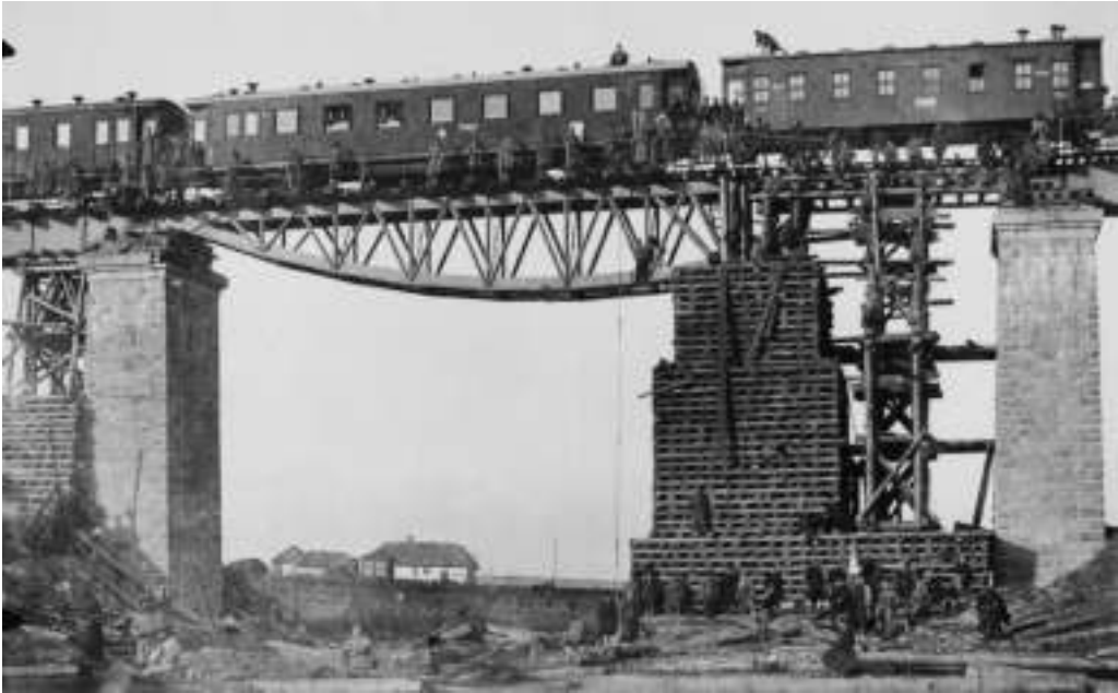
Восстановление железнодорожного моста
